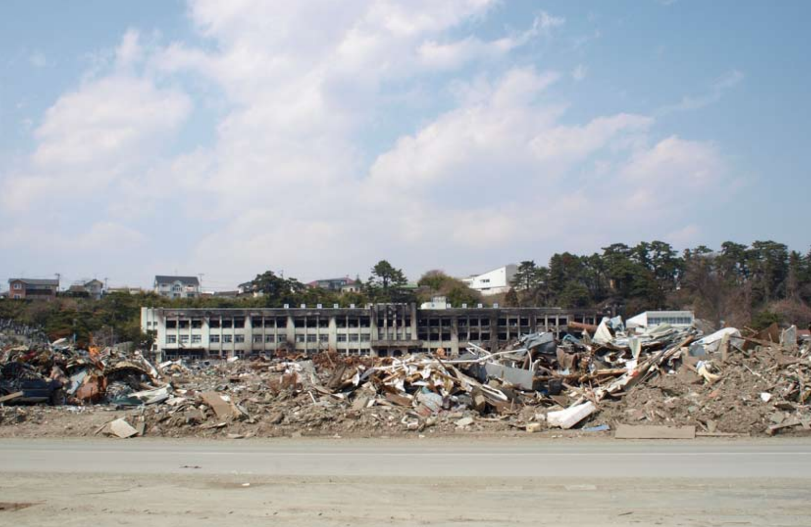
石巻市立門脇小学校付近
